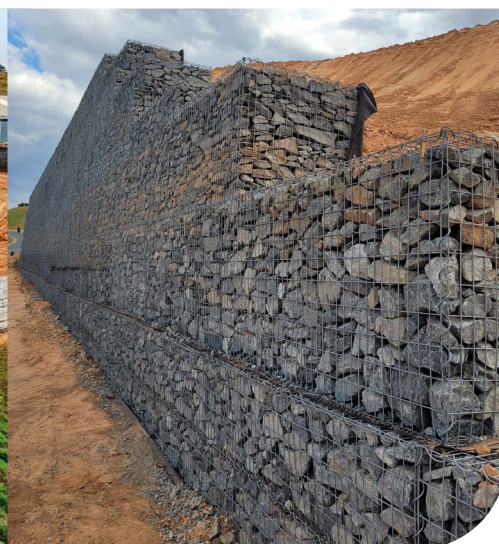
Faceamento com gabiões modulares Belgo Easy®
