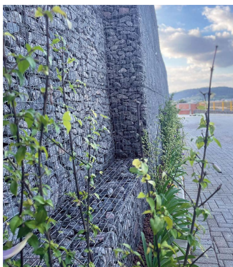
Muro de gravidade com gabiões modulares Belgo Easy®
